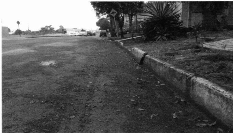
Foto 3 – Av Tito Muffato x Rua Kamayura
