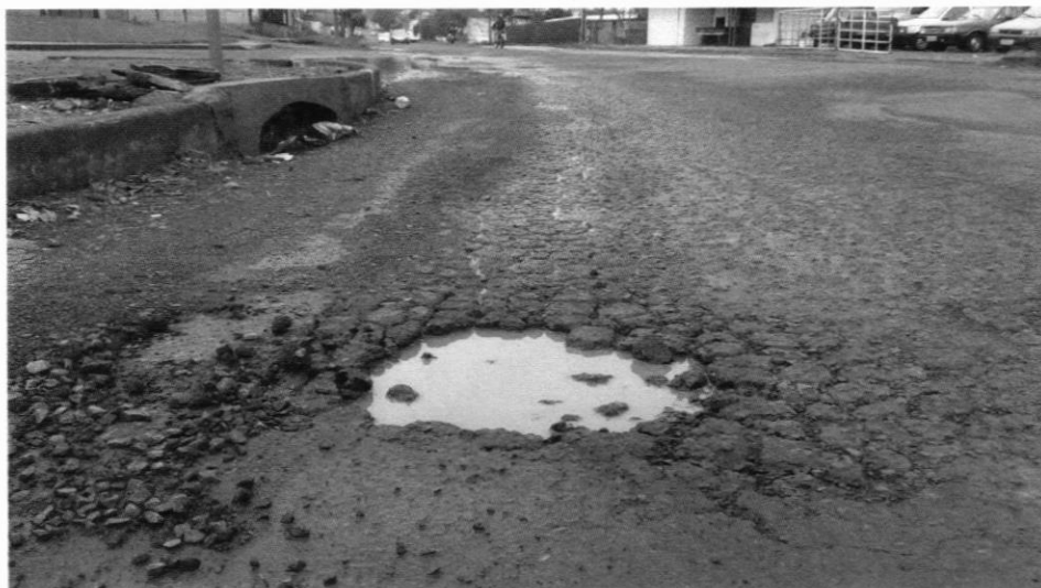
Foto 2 – Av Tito Muffato x Rua Kamayura
