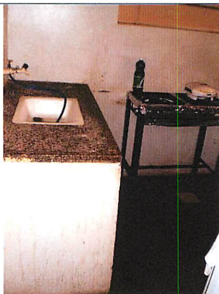
Cozinha Piso Inferior
