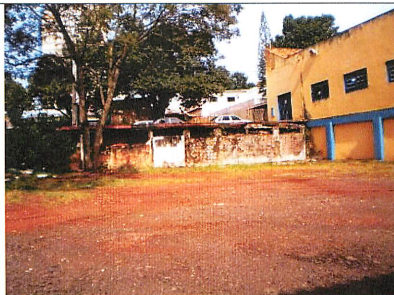
Fachada Lateral e Estacionamento
