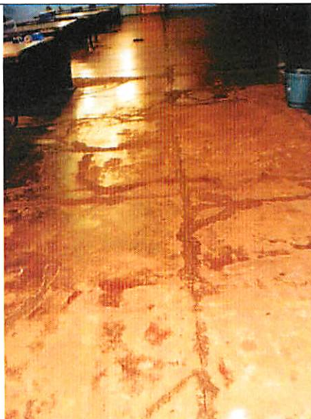
Acabamento Piso Superior
