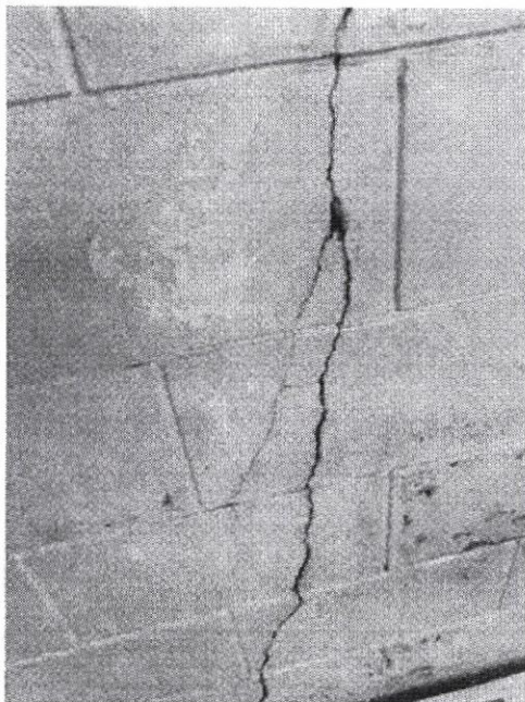
Parede interna e piso do berçário
